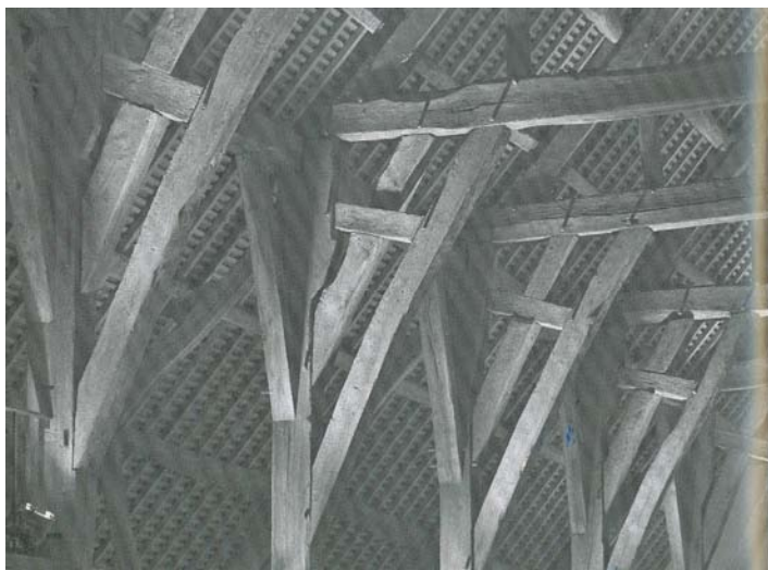
Détail des poutres de la chapelle de l'église abbatiale
