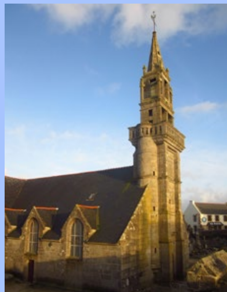
Tréflé : l'église paroissiale Sainte-Ediltrude.
